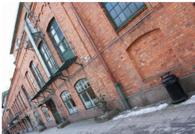
Den gamla tändsticksfabriken som en gång var ryggraden i Jönköpings näringsliv är idag kulturområde. Foto: Wikipedia
